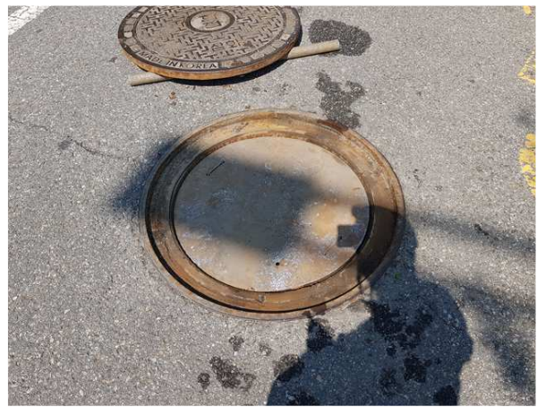
내용 맨홀 내,외부 뚜껑 상태양호
